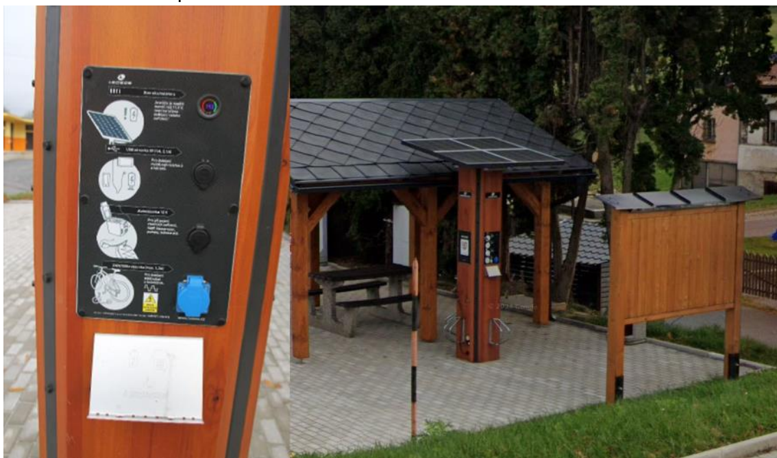
OBR 66: Ukázka nabíjecího bodu v Rynolticích s akumulátorem dobíjeného solárním panelem
